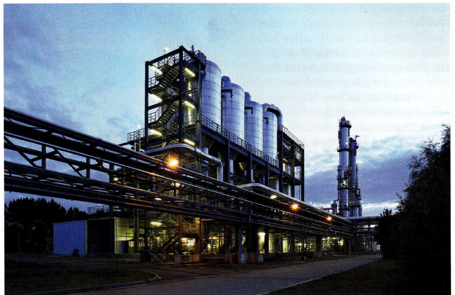
Das Bioethanolwerk der Nordzucker AG in Klein Wanzleben.
