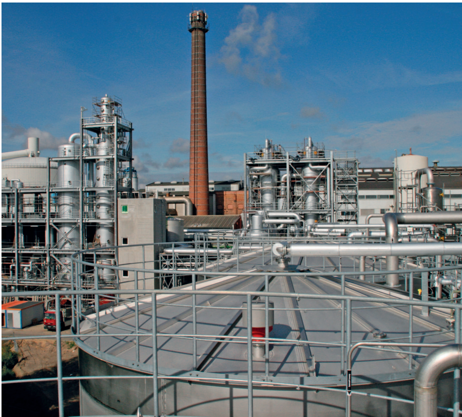
Anlage der Anklam Bioethanol GmbH, ein Unternehmen der niederländischen Suiker Unie, in Mecklenburg-Vorpommern
